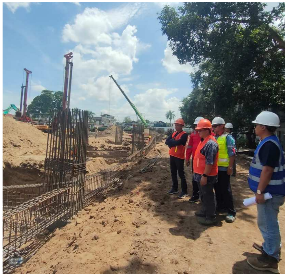
Gambar 2.13 Progres Pembangunan Gedung STMM Yogyakarta
