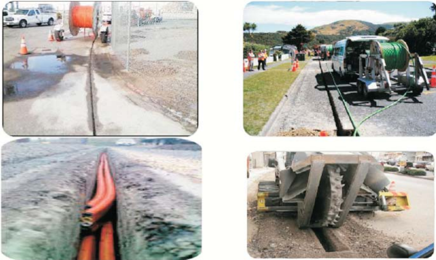
Gambar 9. Teknologi yang digunakan duct sharing Bandung : micro trenching (Abdurachim, 2013)
